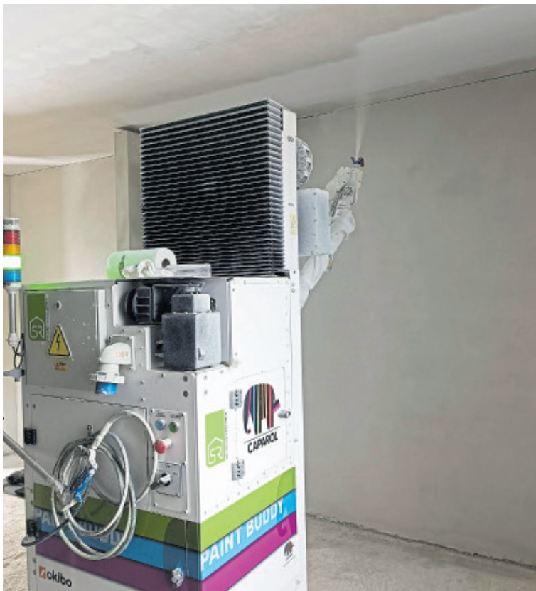
Der Paint Buddy kann Decken mühelos in einer gleichbleibend hohen Qualität streichen ohne müde zu werden. Foto: SR-Malereiunternehmen GmbH
